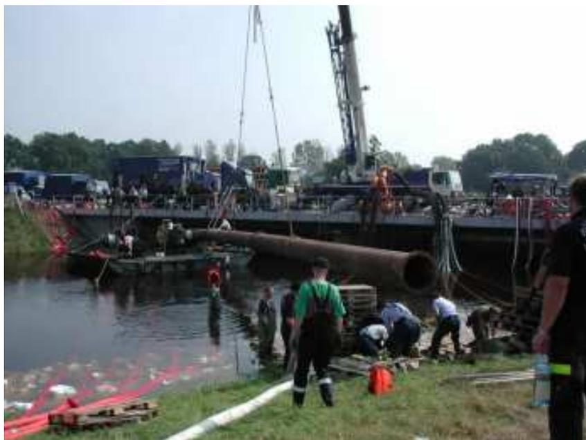
Verlegen von großen Pumprohren für die Niederländischen Hochleistungspumpen an der A9
