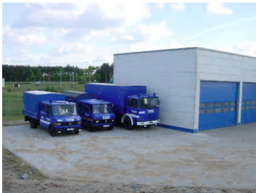
Die neue Fläche kurz nach der Fertigstellung..
