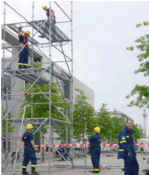
Eberswalder Helfer bauen das Gerüst für die Jugendlichen auf.
