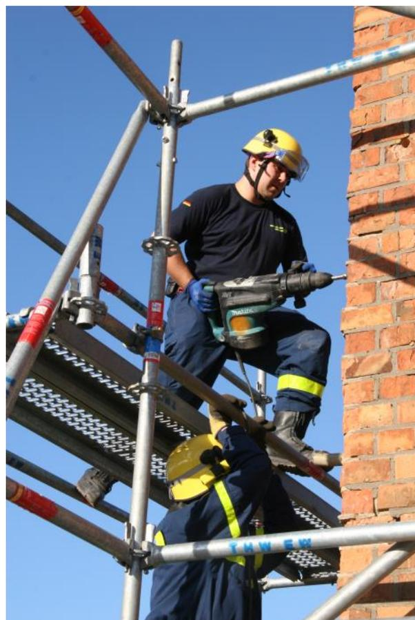
Bohren der Sprenglöcher
