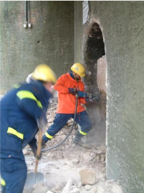
Mit schwerem Gerät wird die Betonwand zur Bunkertür freigelegt
