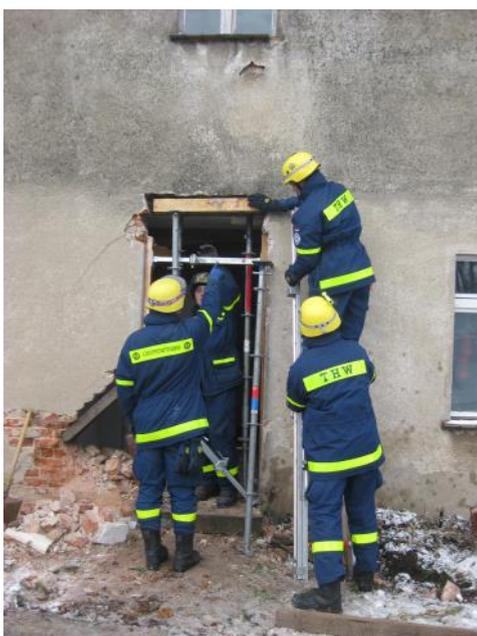
Die beschädigte Hauswand wird mittels EGS abgestützt
