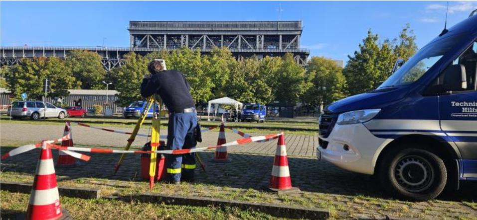
Der Trupp ESS kann kritische Veränderungen an Gebäuden schnell feststellen und so Einsatzkräfte rechtzeitig warnen. Spannend ist festzustellen wie stark eine Gebäude bereits im Normalzustand arbeitet, wie hier am Schiffshebewerk Foto: Alexander Timm
