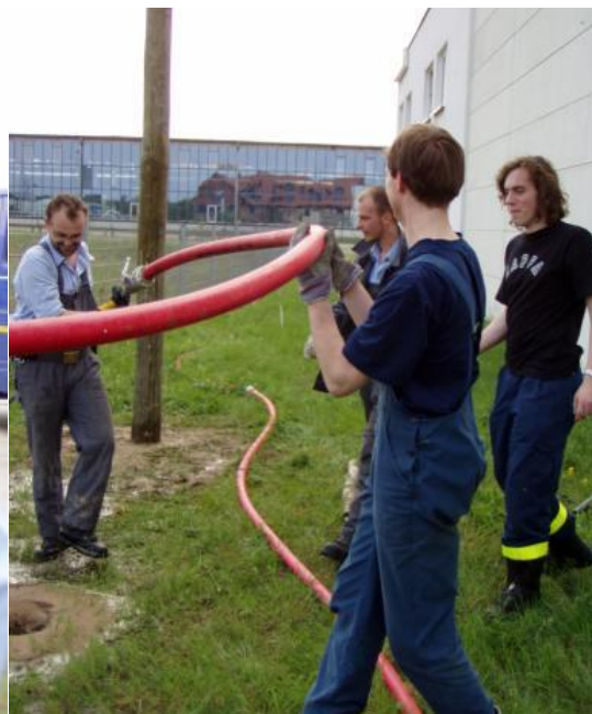
Arbeiten mit der Spüllanze zur Herstellung von Mastlöchern (2006) Foto: THW-Eberswalde
